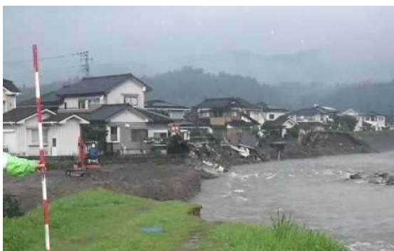
河岸侵食による家屋の倒壊(花月川)
