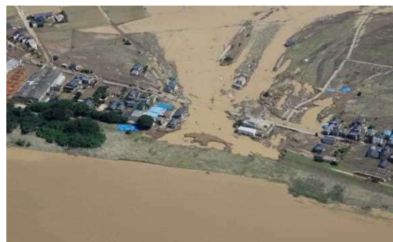
堤防決壊による家屋の流失(鬼怒川)
